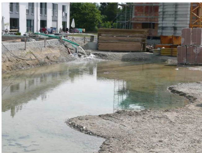
Abb.3.5 links: Seenbildung beim Auspumpen der Tiefgarage in 171/1, rechts: nach Regen und Abtragung des Oberbodens (171/2).
