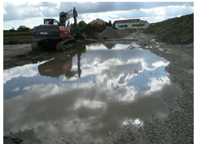
Abb.3.5 links: Seenbildung beim Auspumpen der Tiefgarage in 171/1, rechts: nach Regen und Abtragung des Oberbodens (171/2).
